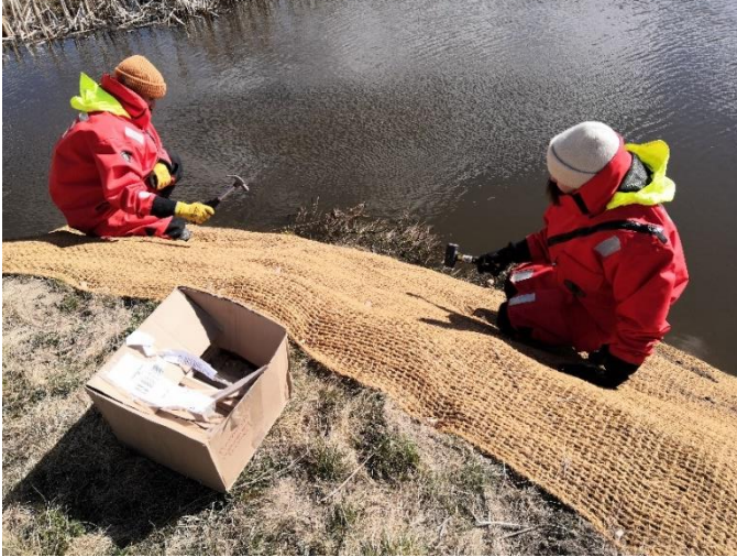
Kuva 6. Kookoskuituisen eroosiomaton asennus puukiinnikkein tekosaarien jyrkimpien ja romahtamisaltteimpien, paljaiden rinteiden osille (3.-4.5.2022). Oikealla lähikuva eroosiomattotuotteesta.
